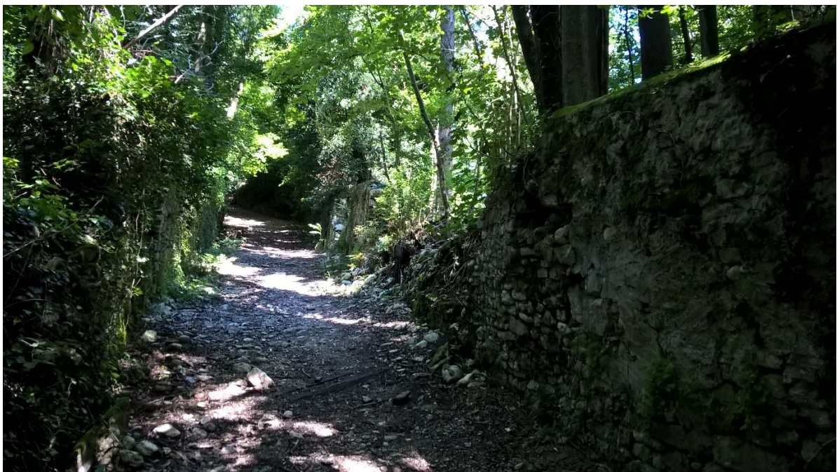
Strada di collegamento al fiume Piave, delimitata da muri fatiscenti
