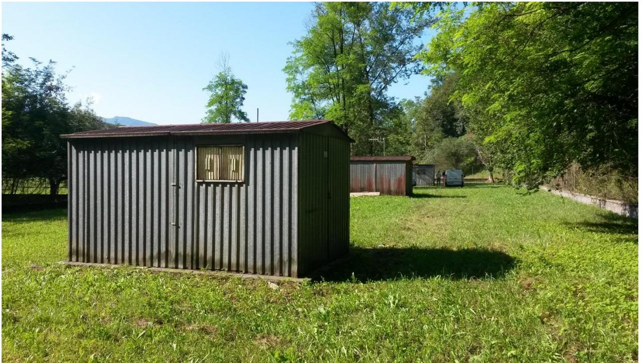
I basamenti su cui sono stati costruiti gli impianti, sono di tipo a platea delle dimensioni di circa 3,00 m. x 4,50 m. (per due stazioni) e 3,00 m. x 5,50 m. I manufatti di protezione, costituiti da montantini in acciaio con lamiere di protezione esterne, presentano un aspetto vetusto con corrosione diffusa ed evidenti segni di deterioramento in più parti (quali fessure, marciume ecc.), in particolare localizzate sul basamento.
