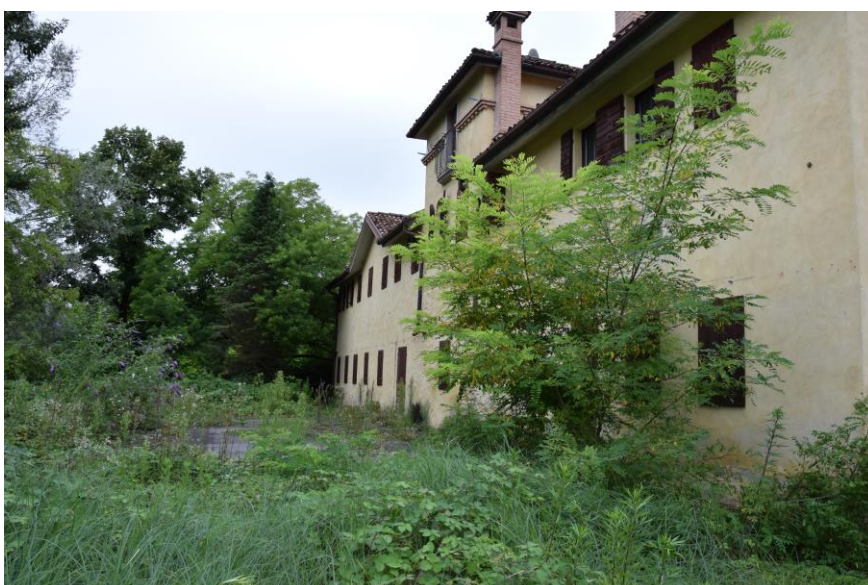
Vista del corpo di fabbrica affacciato al fiume Piave (sud-est)
