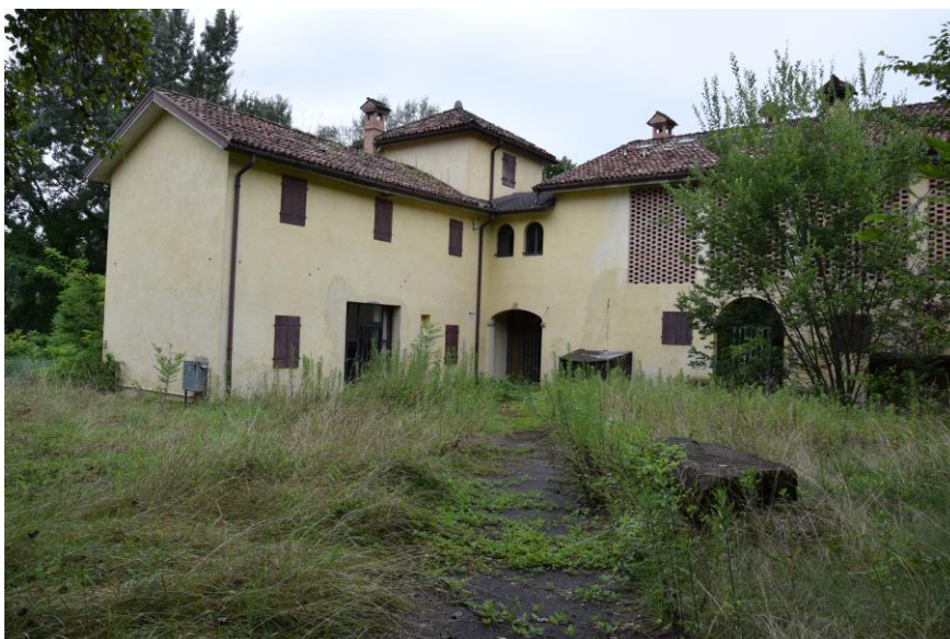
Vista dalla carpenada (nord-est)
