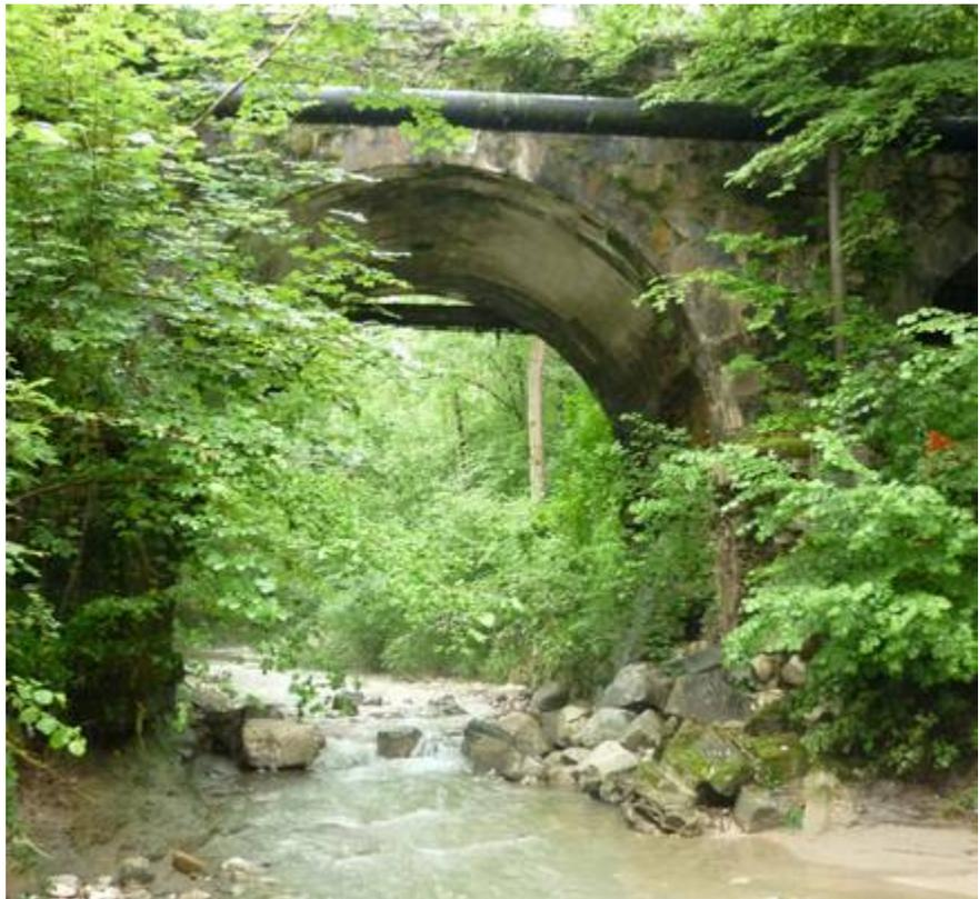
Località Casoni – ponte sul torrente, vista dall'alveo con in evidenza i gravissimi crolli che interessano la pila 1.
