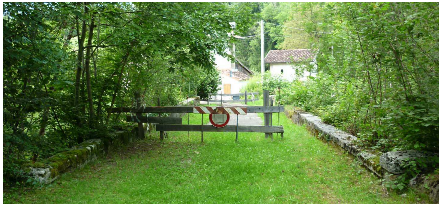
Località Casoni – tratto finale della pista ciclabile e imbocco ponte
