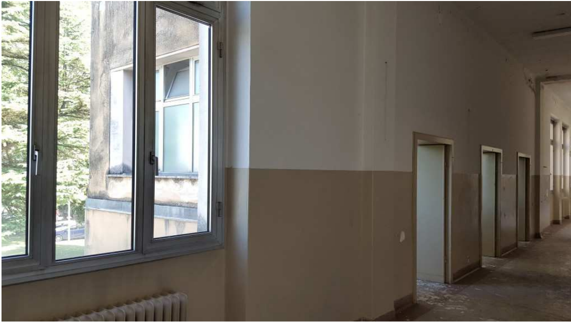
Fig. 21 – Corridoio dell'ala ovest al piano primo con, sulla sinistra, il blocco servizi igienici.
