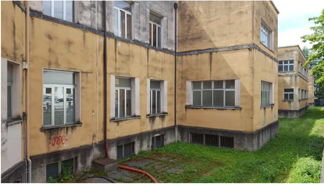
Fig. 13 – Lato nord dell'ala ovest.
