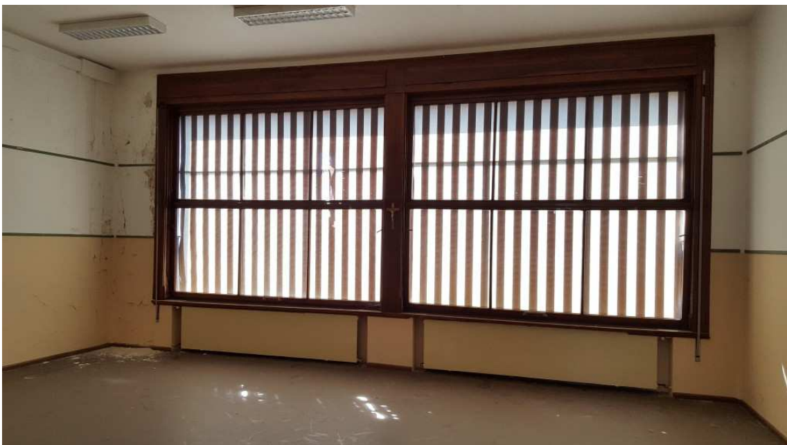
Fig. 22 – Interno di un'aula al piano primo.
