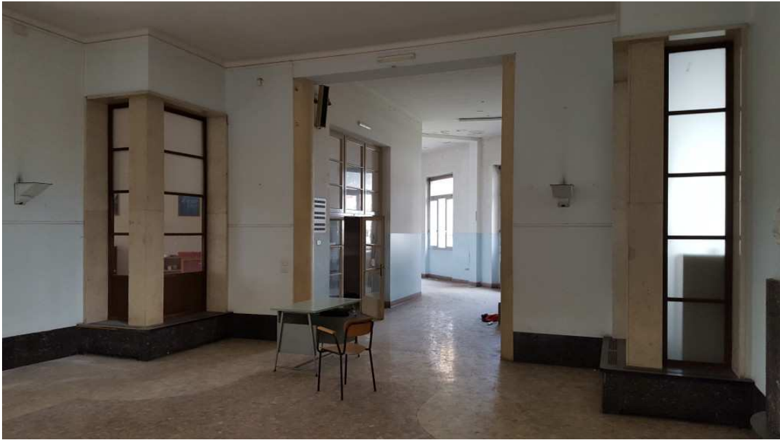
Fig. 15 – Collegamento all'ala ovest dall'atrio di ingresso.
