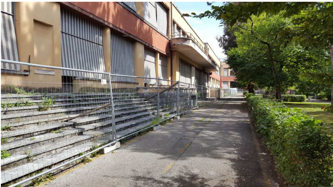
Fig. 8 – Lato sud (principale) dell'ala ovest.
