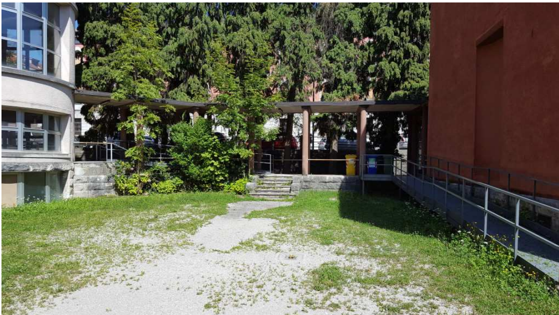
Fig. 14 – Tettoia di collegamento tra la scuola, a sinistra, e la palestra, a destra.
