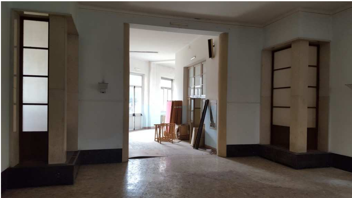
Fig. 16 – Collegamento all'ala sud dall'atrio di ingresso.
