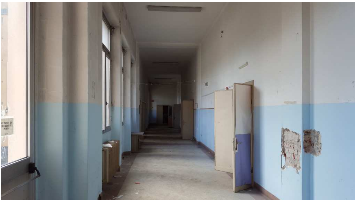
Fig. 18 – Corridoio dell'ala ovest al piano rialzato.
