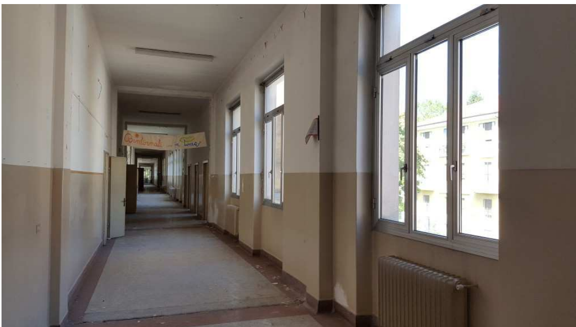
Fig. 20 – Corridoio dell'ala ovest al piano primo.
