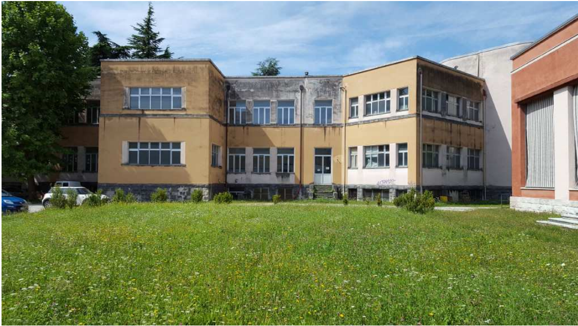
Fig. 11 – Ala sud e, sulla destra, scorcio della palestra.
