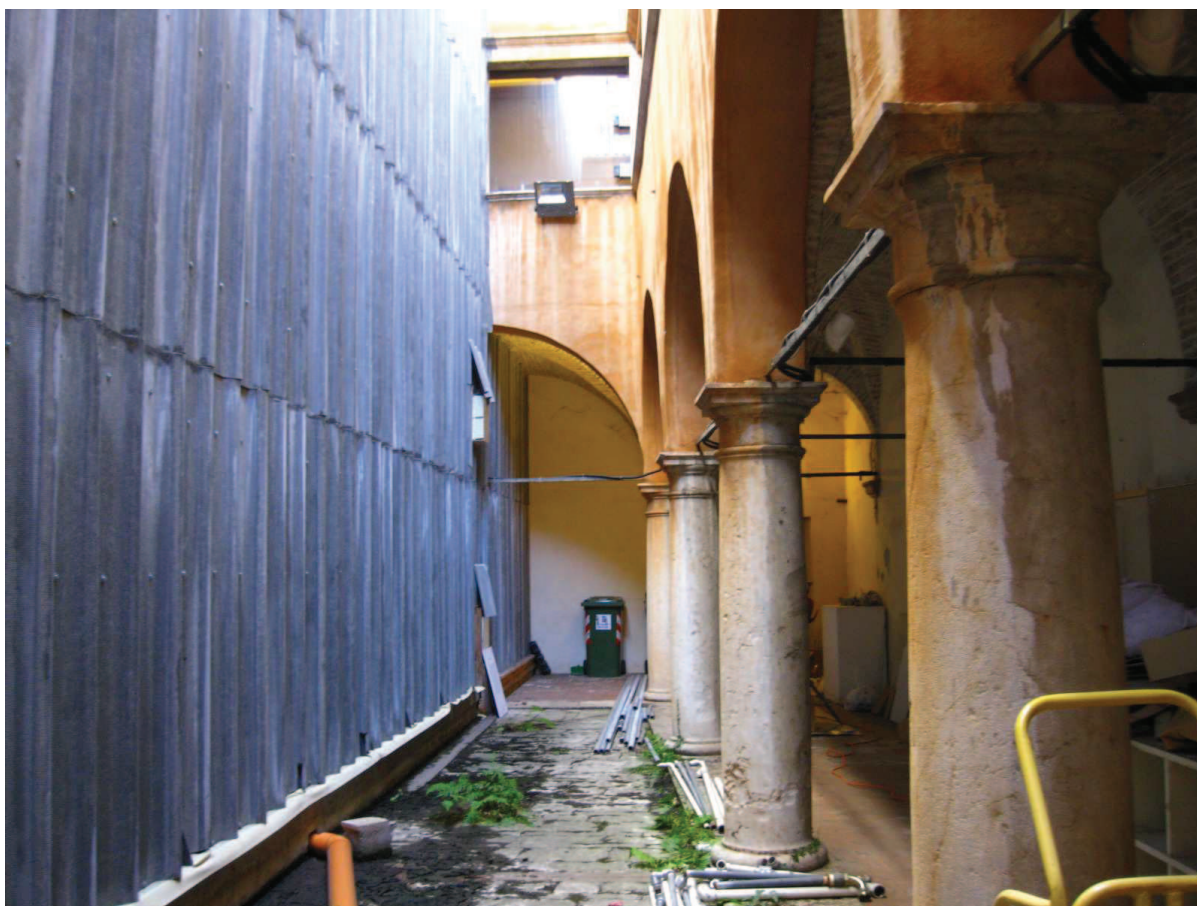
6 -La corte interna, lato sud. Il palazzo, sulle facciate rivolte a nord e a ovest, è caratterizzato da porticato con colonne in pietra. Allo stato attuale parte del porticato sulla facciata rivolta a ovest fa parte del Padiglione espositivo.
