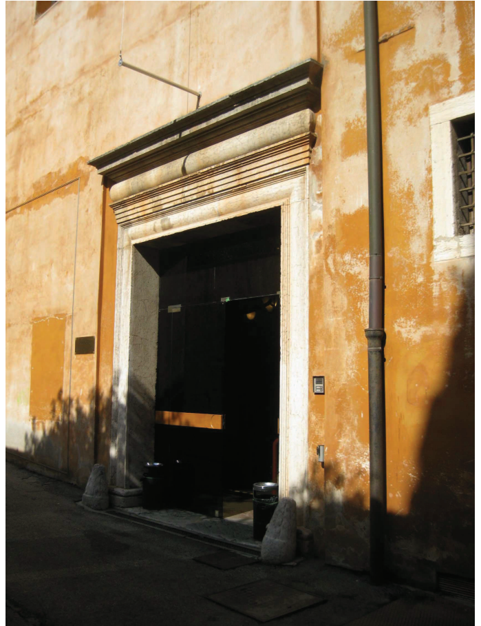
2-L'ingresso alla biblioteca e alla corte interna
