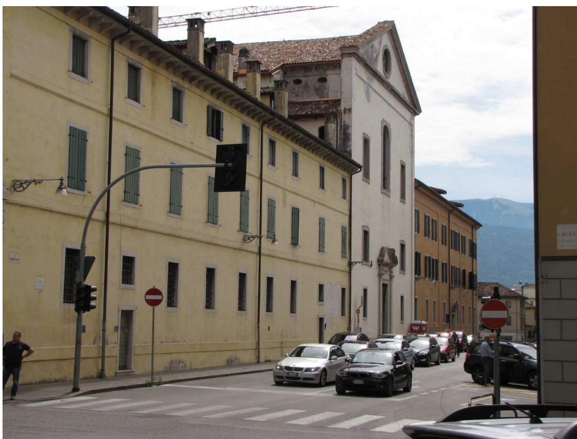
Fig. 8 – La facciata del compendio su Via Tasso con, al centro, la Chiesa.
