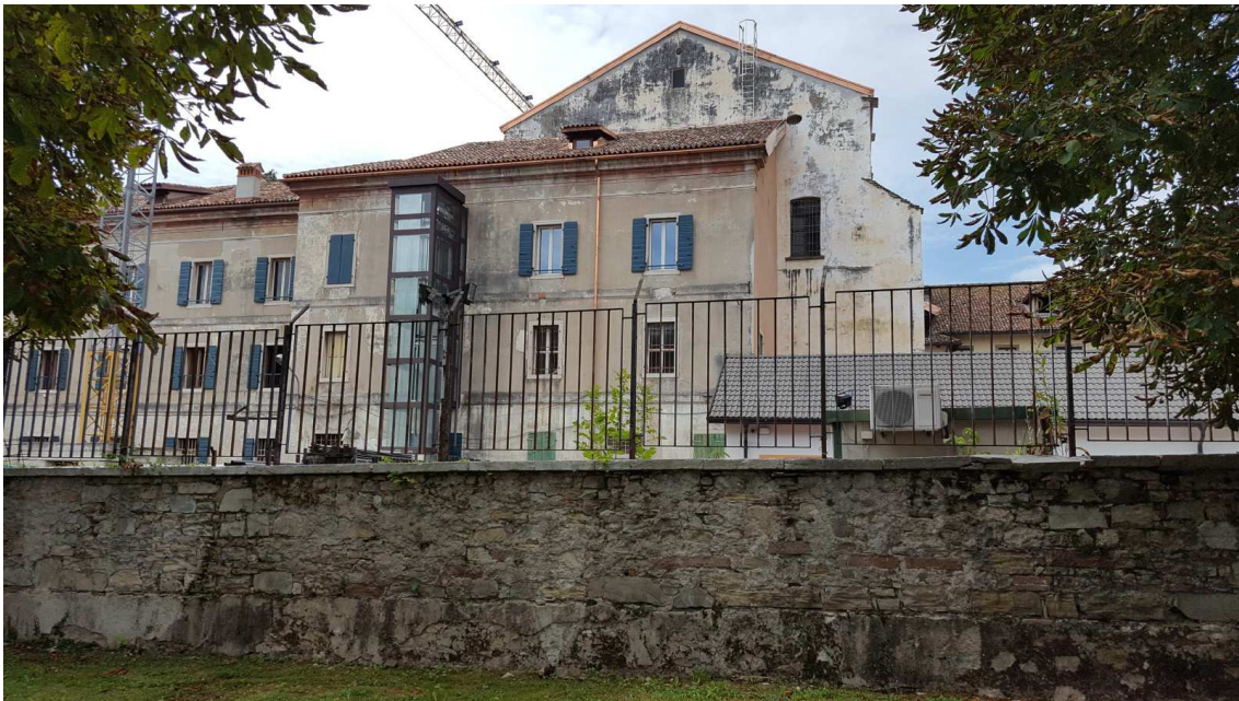
Fig. 10 – Prospetto est dal Parco Città di Bologna.
