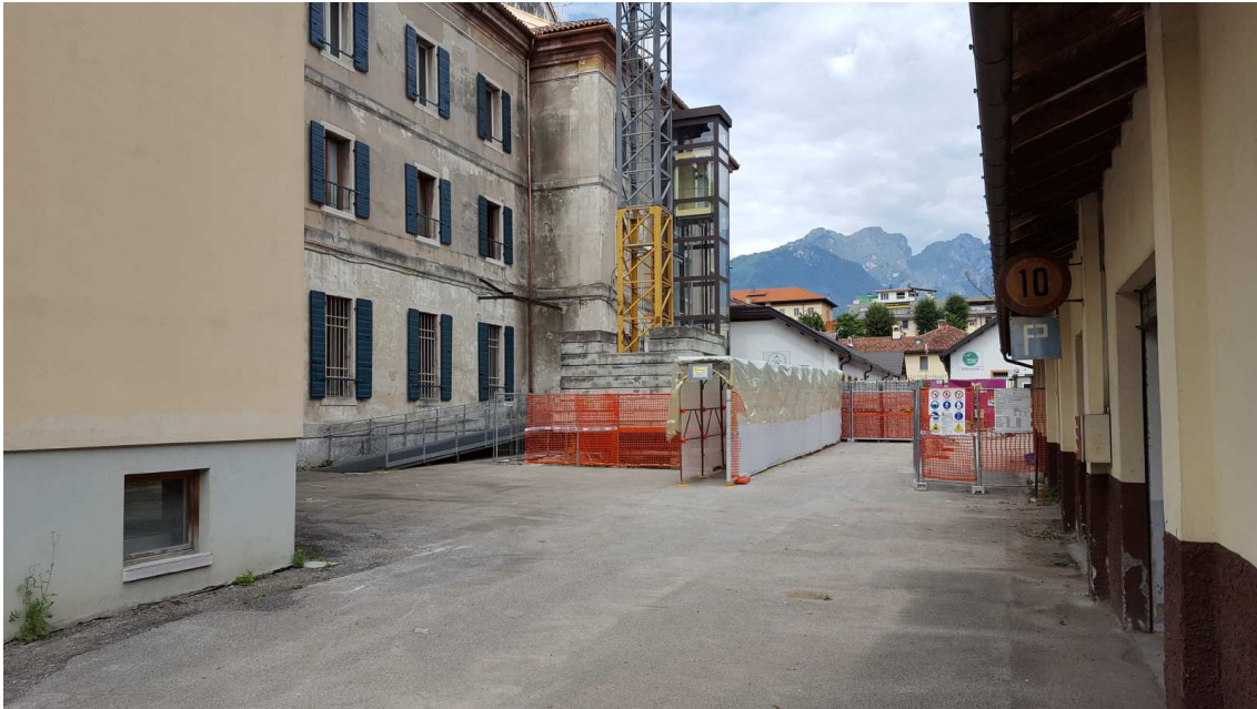
Fig. 11 – Vista laterale del prospetto est.
