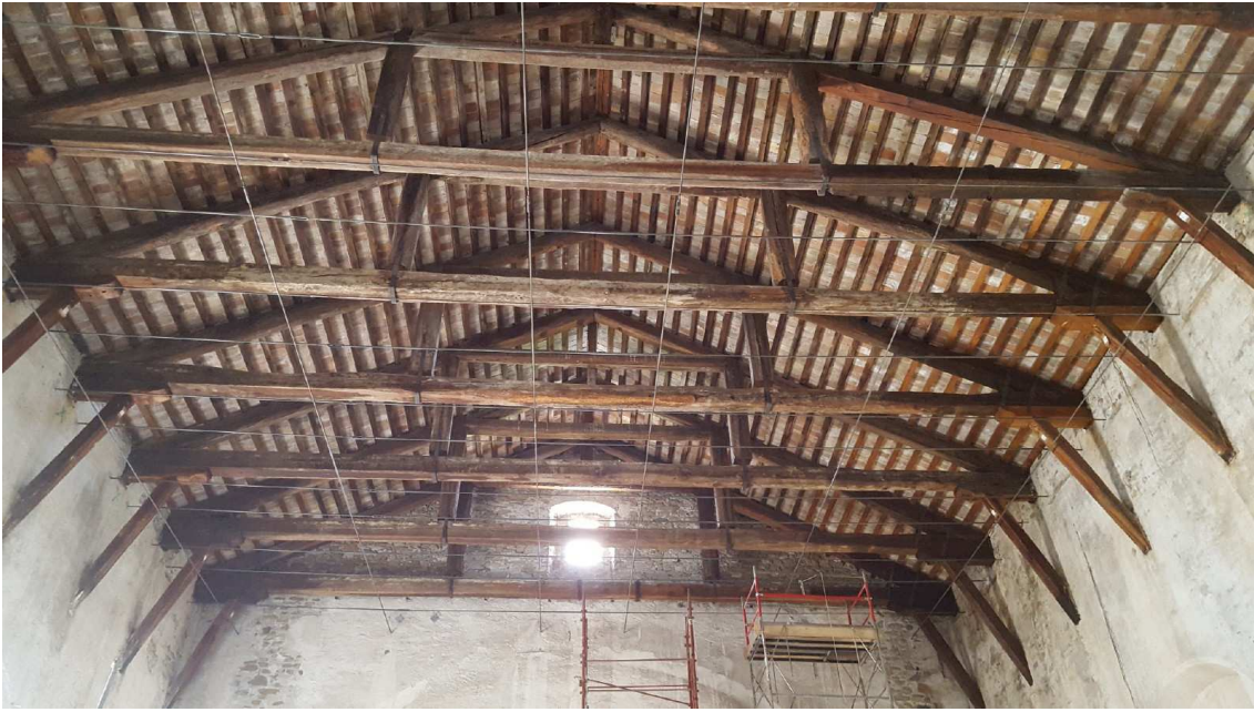
Fig. 13 – Dettaglio della copertura.
