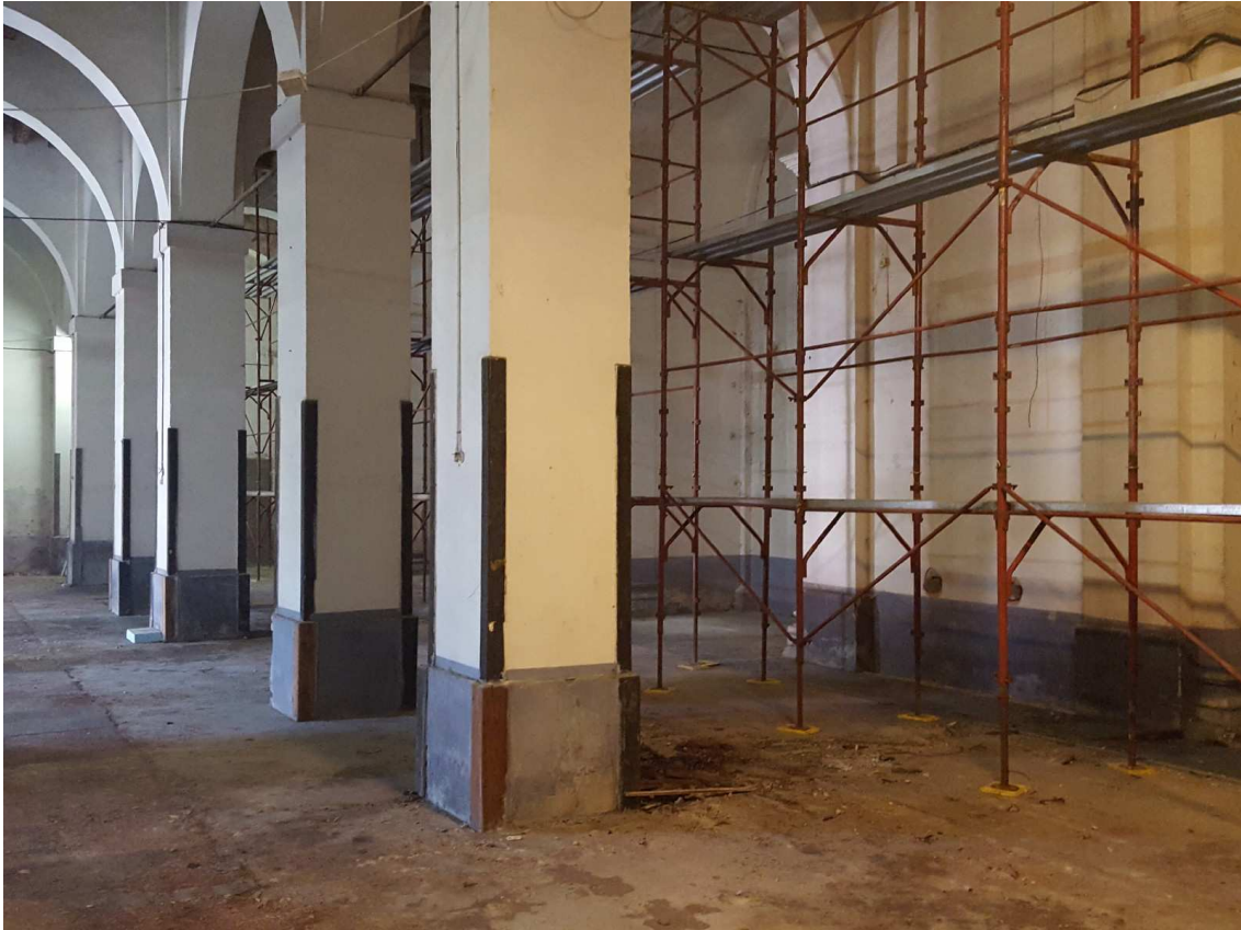
Fig. 17 – Navate centrale e laterale destra.
