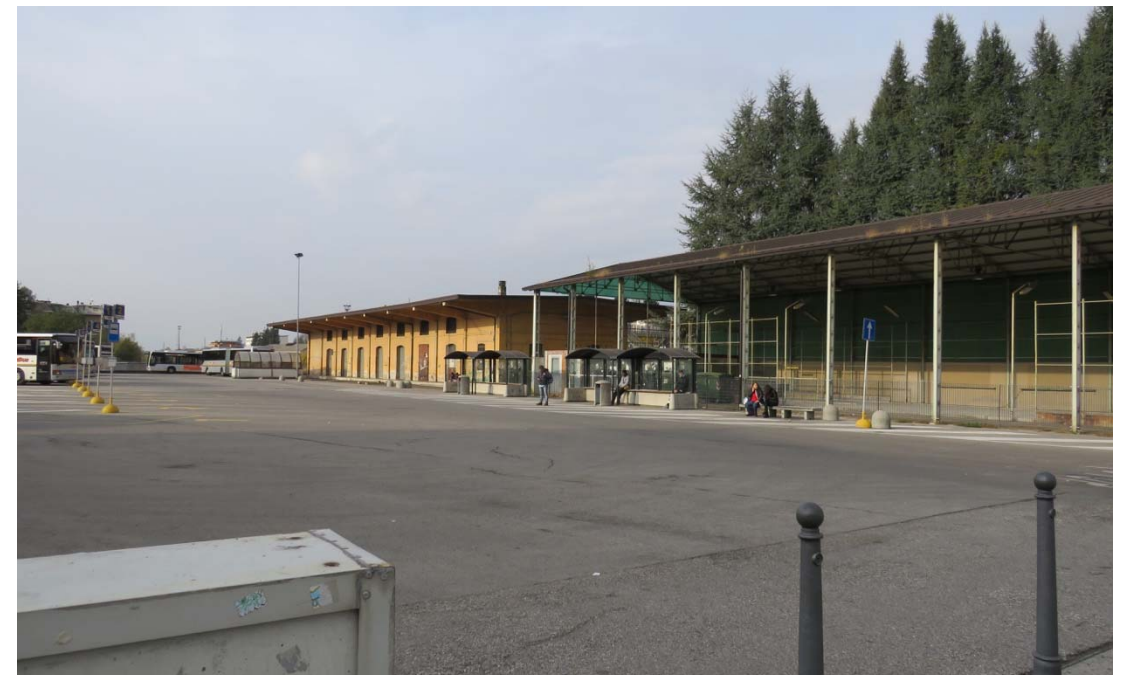
Vista degli edifici ferroviari dismessi
