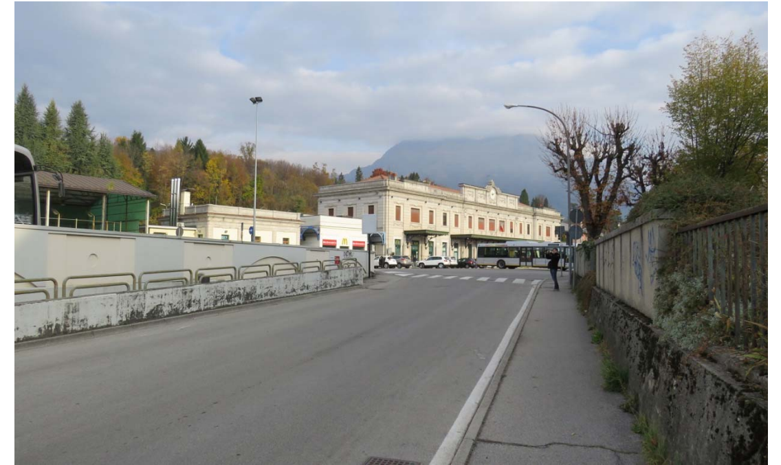
Piazzale della Stazione visto da Via Carducci
