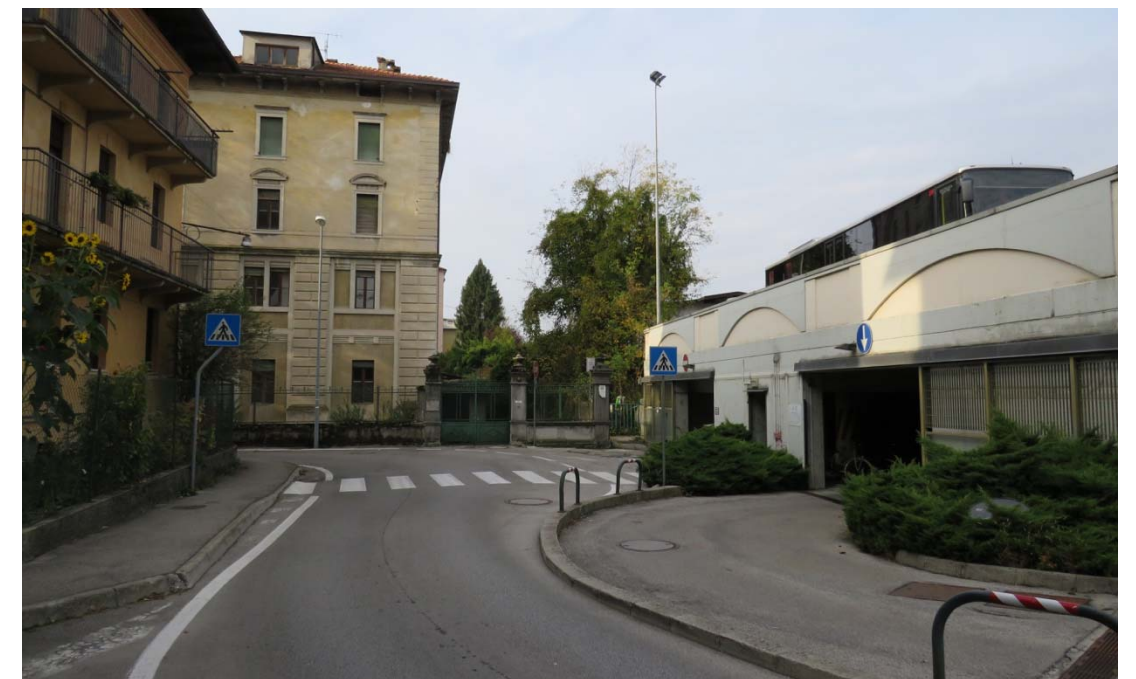
Vista dell'ingresso al parcheggio sottostante il Piazzale Metropolis
