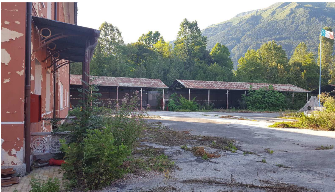
Fig. 6 - Vista della zona ovest con, sulla sinistra, l'edificio 4 e, al centro, le tettoie 1 e 2.
