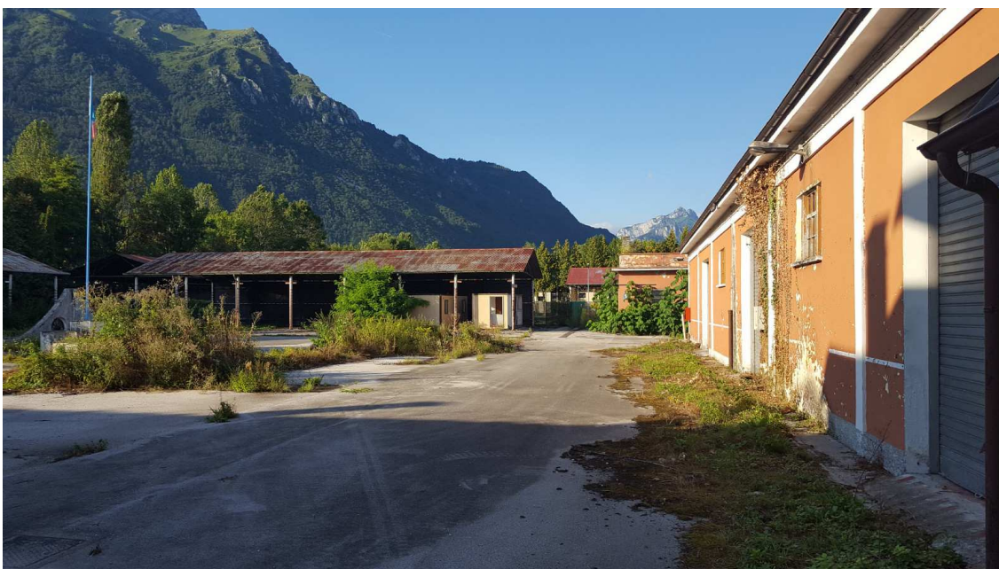
Fig. 7 - Vista della zona ovest con, al centro, la tettoia 3.
