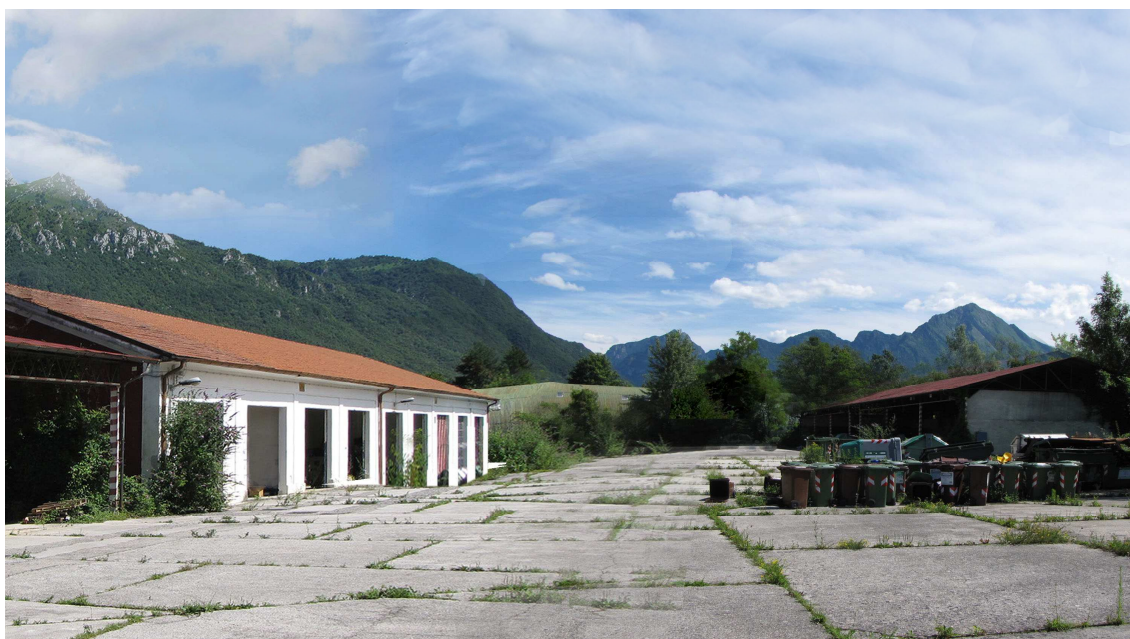
Fig. 23 – Vista attuale della zona est.
