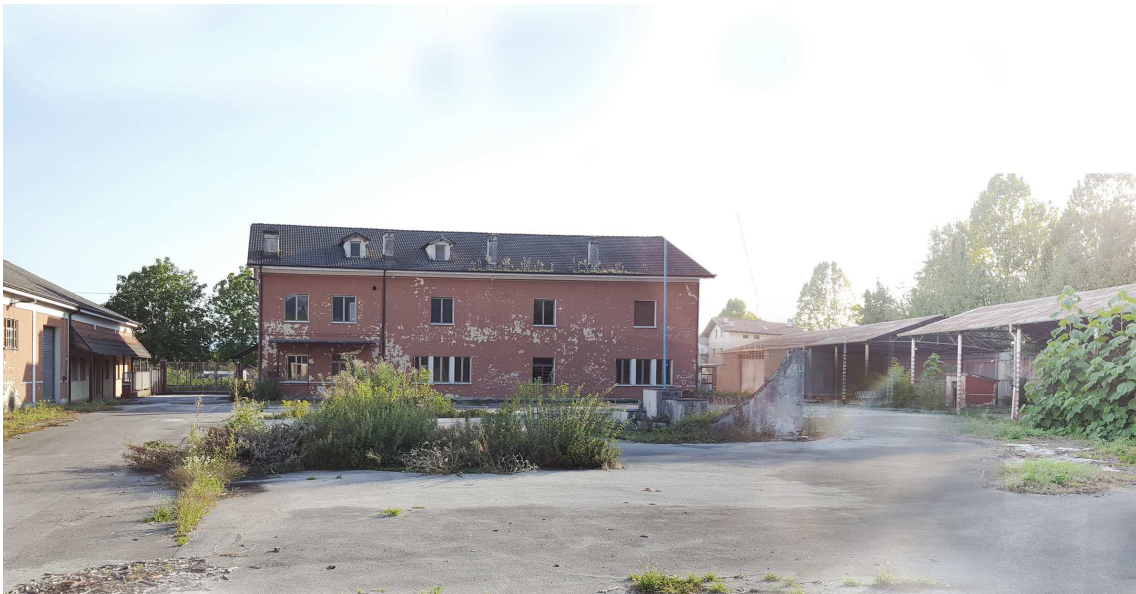
Fig. 21 – Vista attuale della zona ovest.
