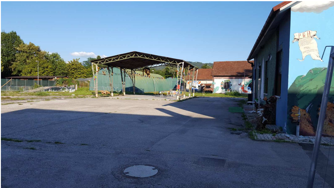
Fig. 11 - Vista della zona centrale con, al centro, la tettoia 9.
