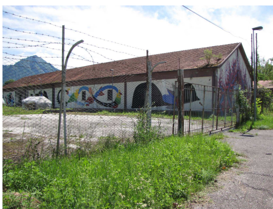
Fig. 18 - Recinzione: stato di fatto.
