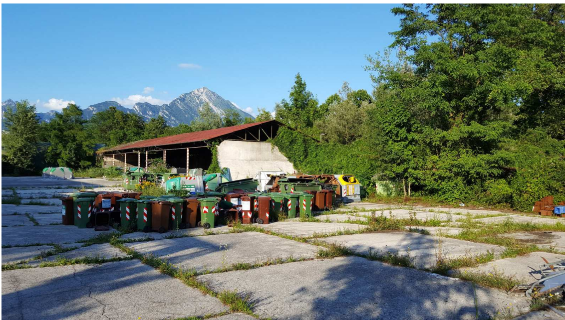
Fig. 15 - Vista della zona est con, sulla destra, la tettoia 18.
