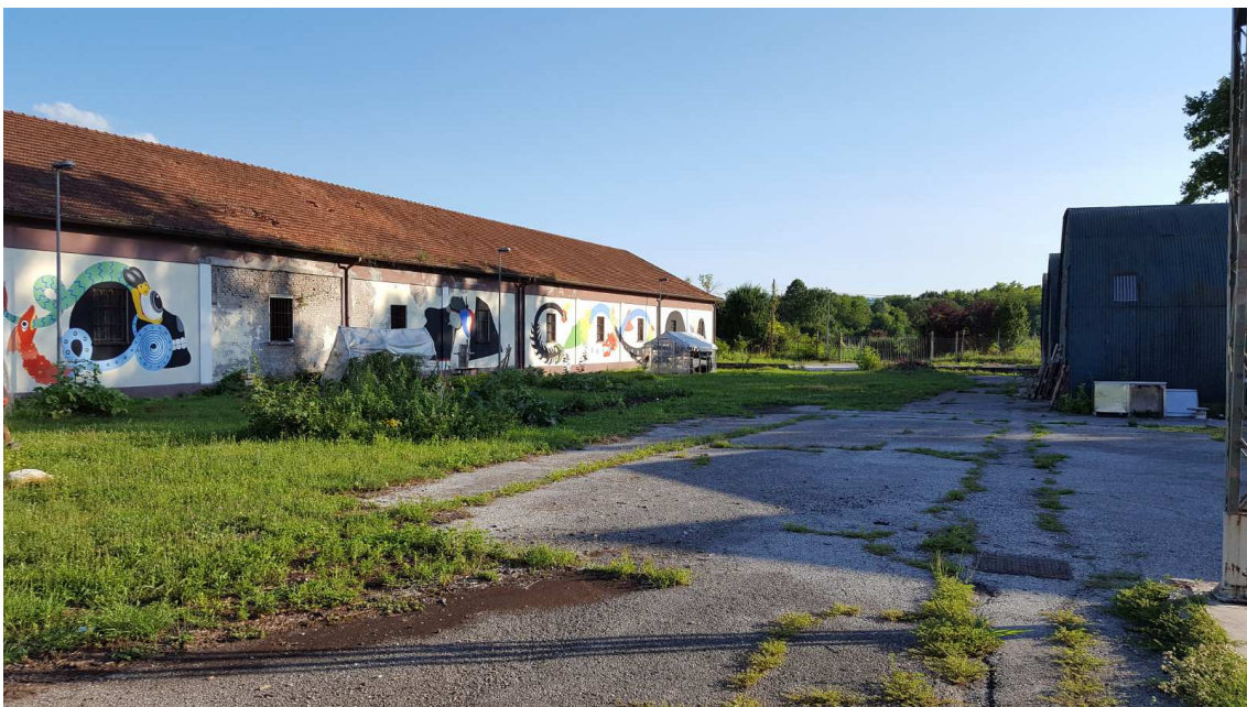
Fig. 13 - Vista della zona centrale con, sulla sinistra, l'edificio 15.
