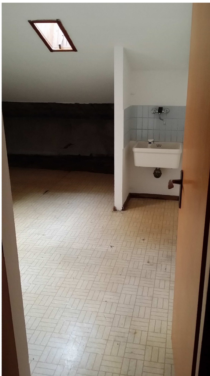
Scorcio pavimentazione stanza al piano secondo
