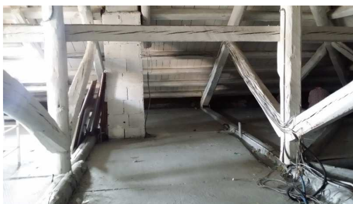
Vista della struttura di copertura al piano sottotetto
