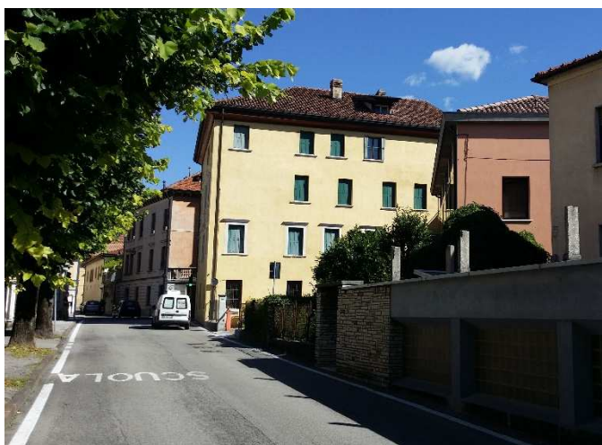
Fronte sud visto da Via del Piave
