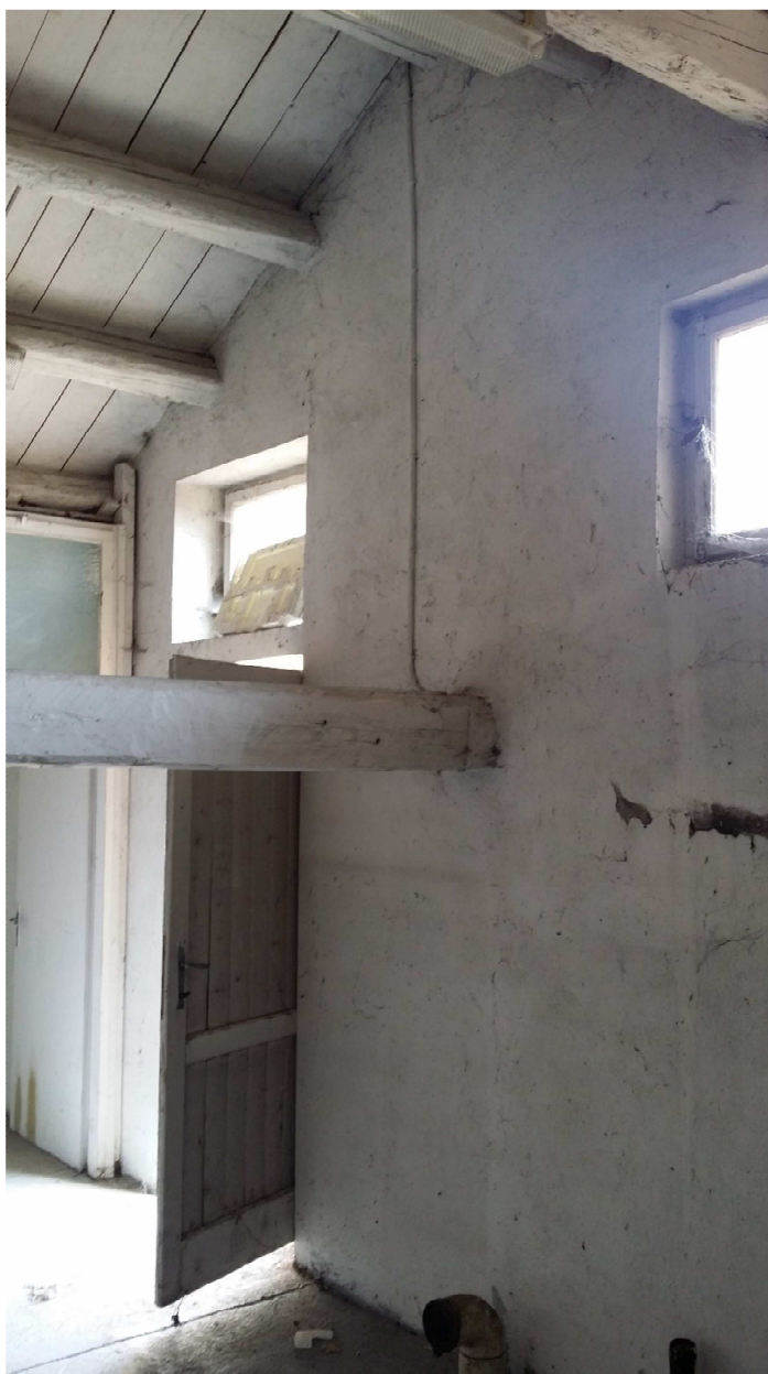
Timpano sul lato est del sottotetto
