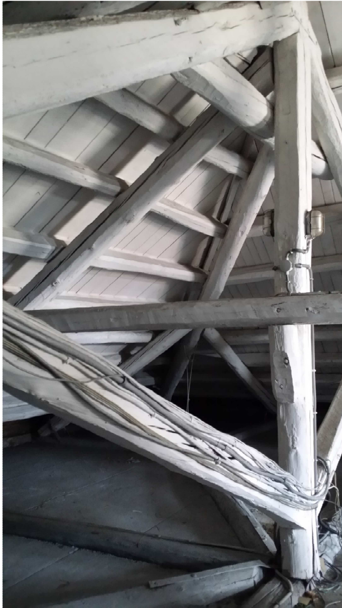
Particolare di un nodo del tetto a padiglione
