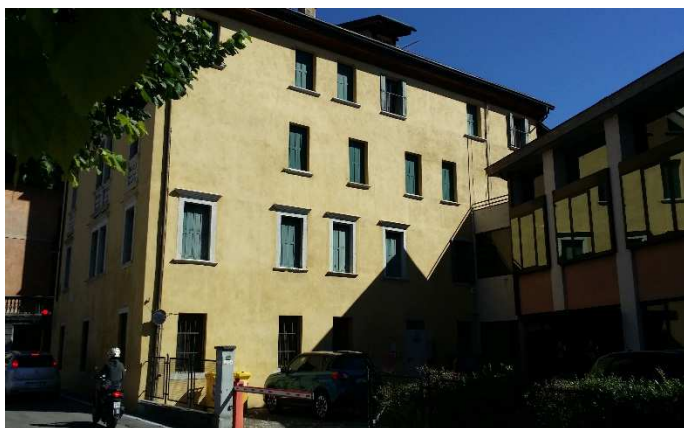
Fronte sud su corte di proprietà
