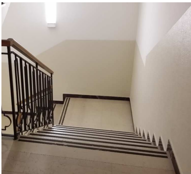
Arrivo della scala al piano primo
