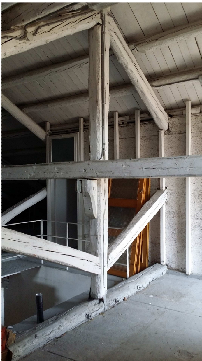
Una delle capriate lignee del tetto
