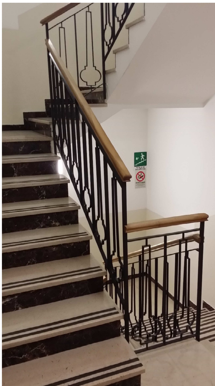
Vista della scala dal piano secondo
