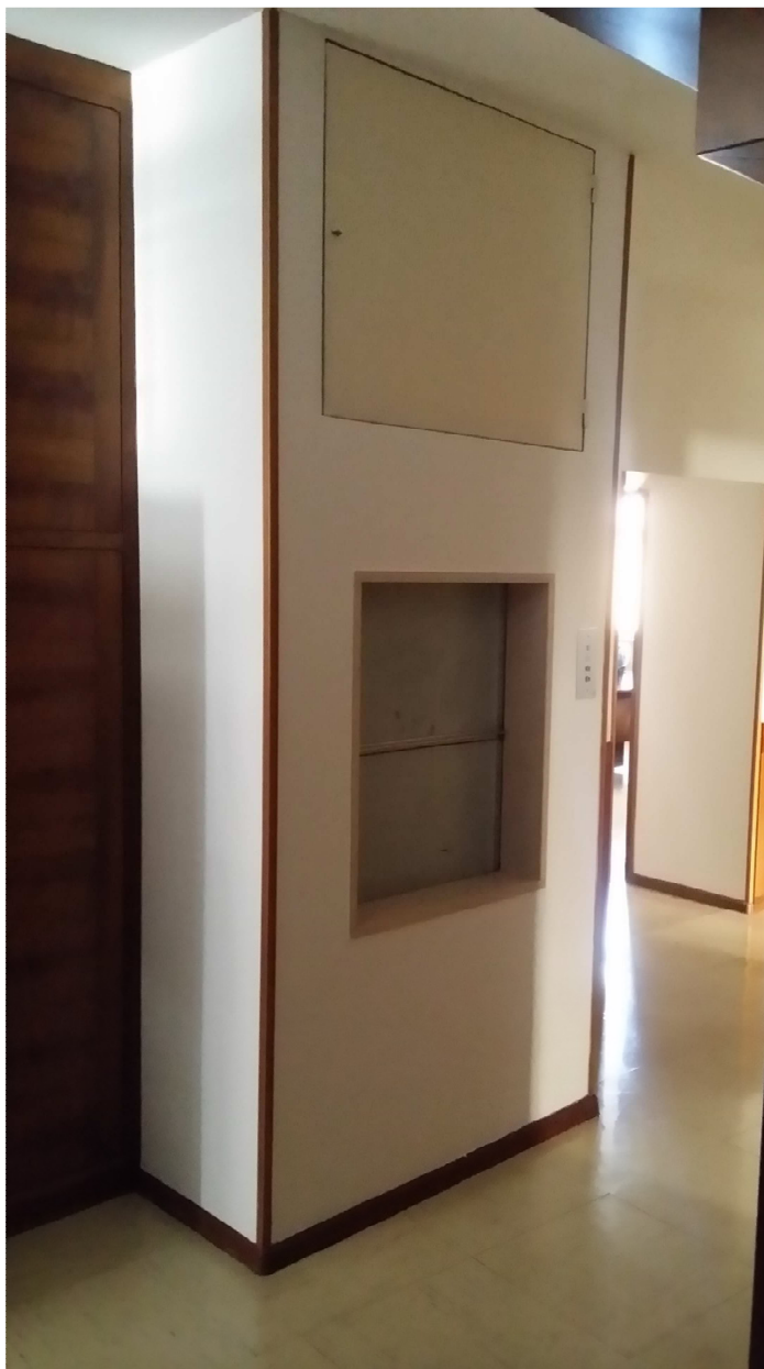
Montacarichi al piano primo
