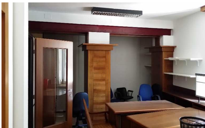
Pilastri e putrelle in ferro al piano primo
