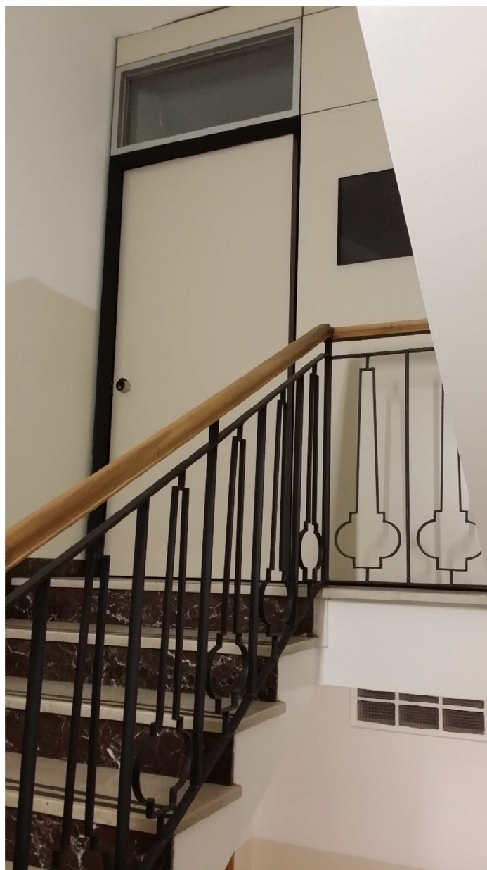
Arrivo della scala al piano terzo
