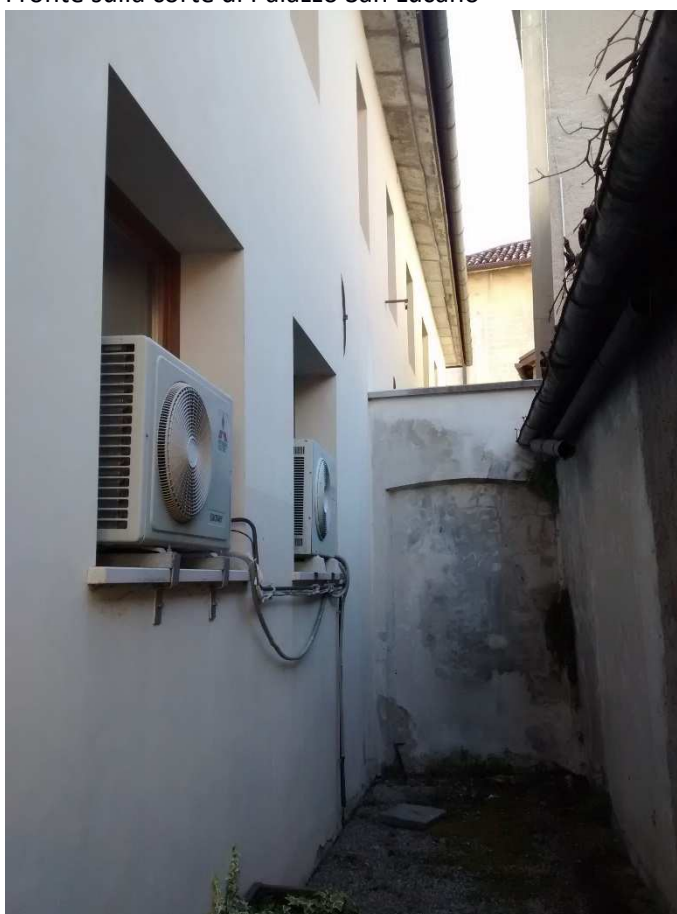
Fronte sulla corte esclusiva
