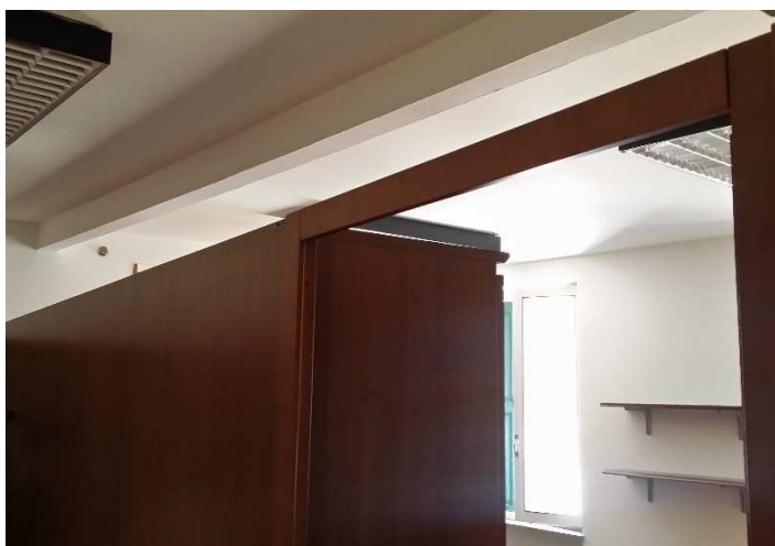
Trave a soffitto al piano primo
