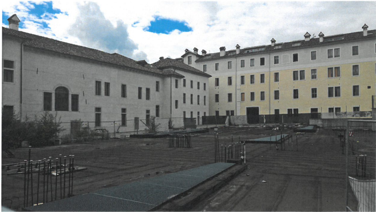
Vista dell'area, di Palazzo Bembo e Palazzo Caffi
