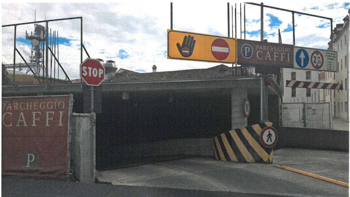
Ingresso del parcheggio Caffi
