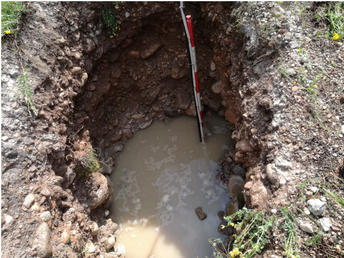
Figura 2 - Trincea di scavo durante l'esecuzione della prova.
