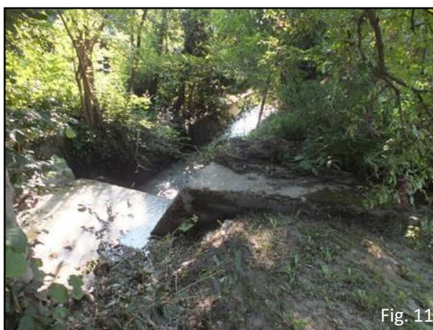
Fig.11: Le opere di protezione alla sponda sinistra del corso d'acqua.
