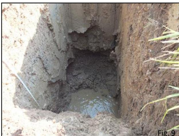
Fig.9: Lo scavo effettuato; da notare la presenza di acqua sul fondo e sui lati.
