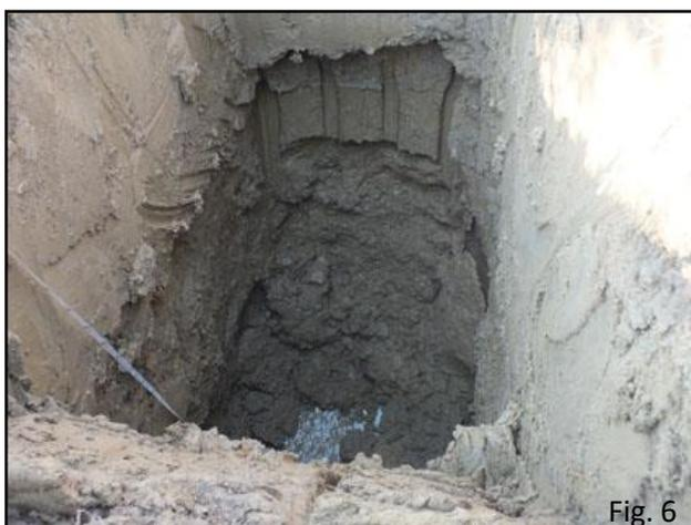
Fig.6: Lo scavo effettuato; da notare la presenza di acqua sul fondo e sui lati.
