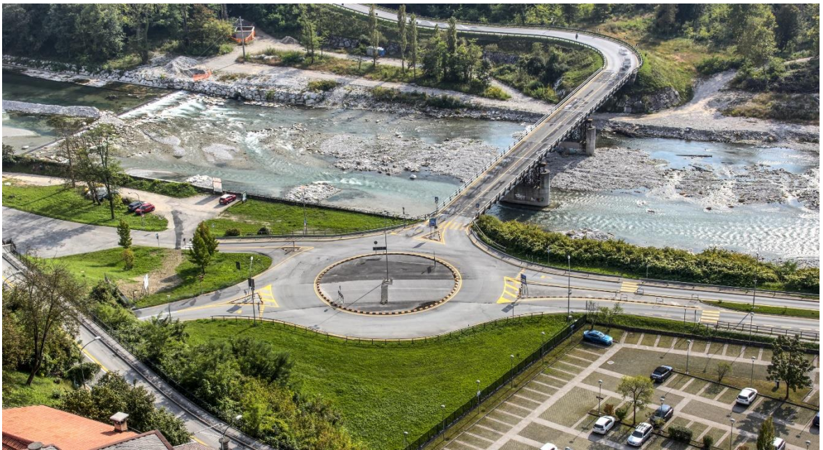
Figura 2. Rotonda e attraversamento provvisorio Ponte Bailey
