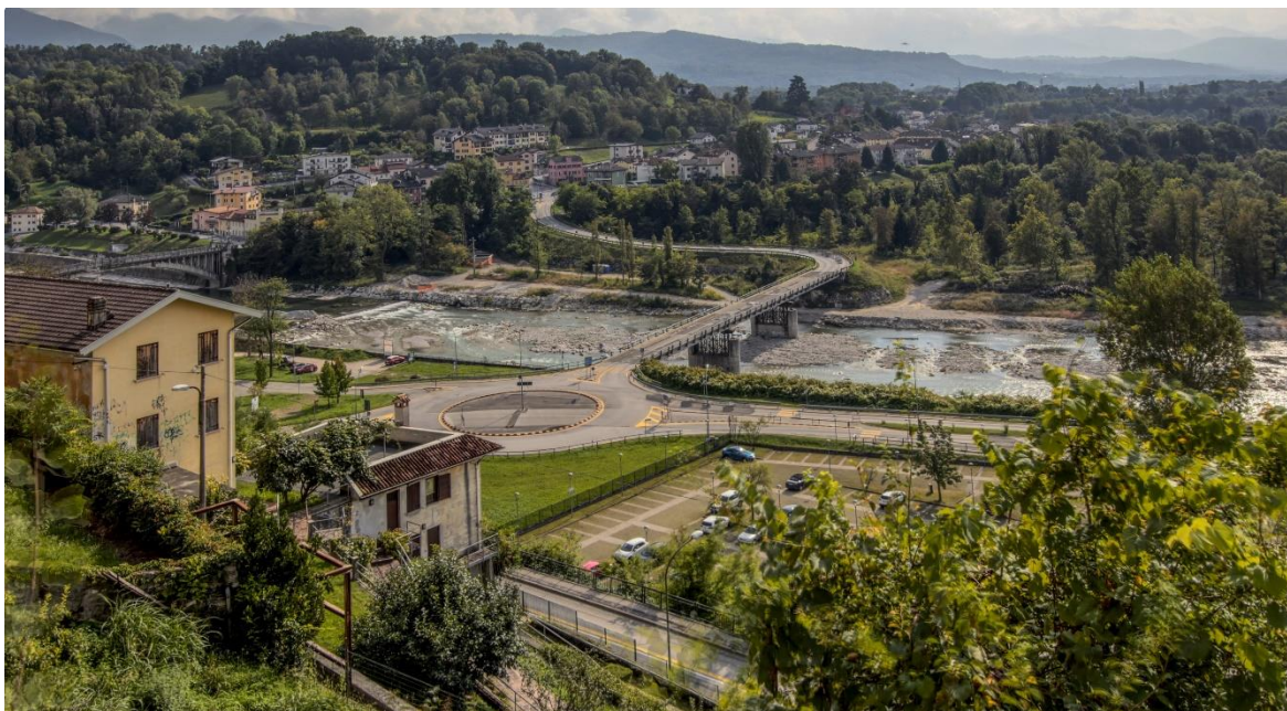
Figura1. Collegamento provvisorio Ponte Bailey
