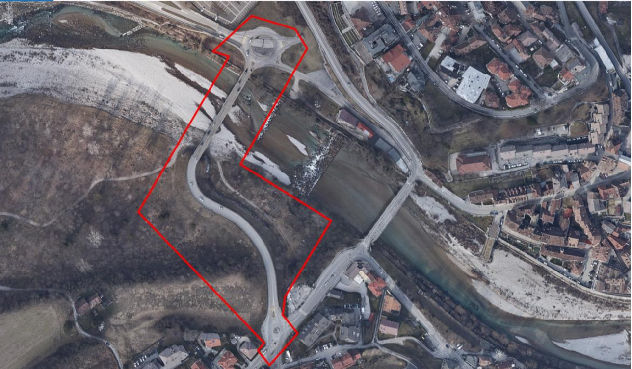
Area di cantiere
