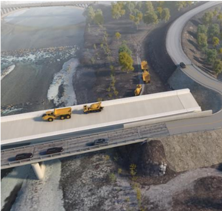
Costruzione del nuovo accesso
