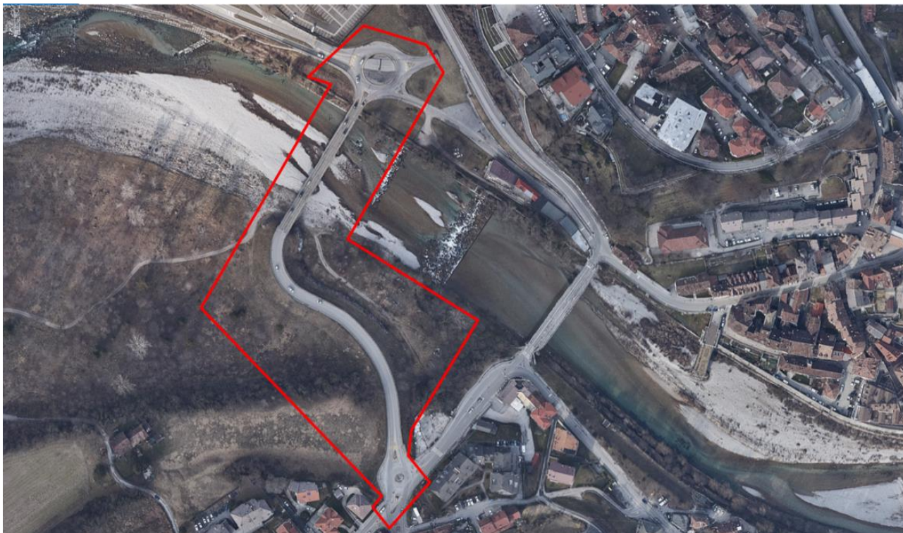
Area di cantiere
