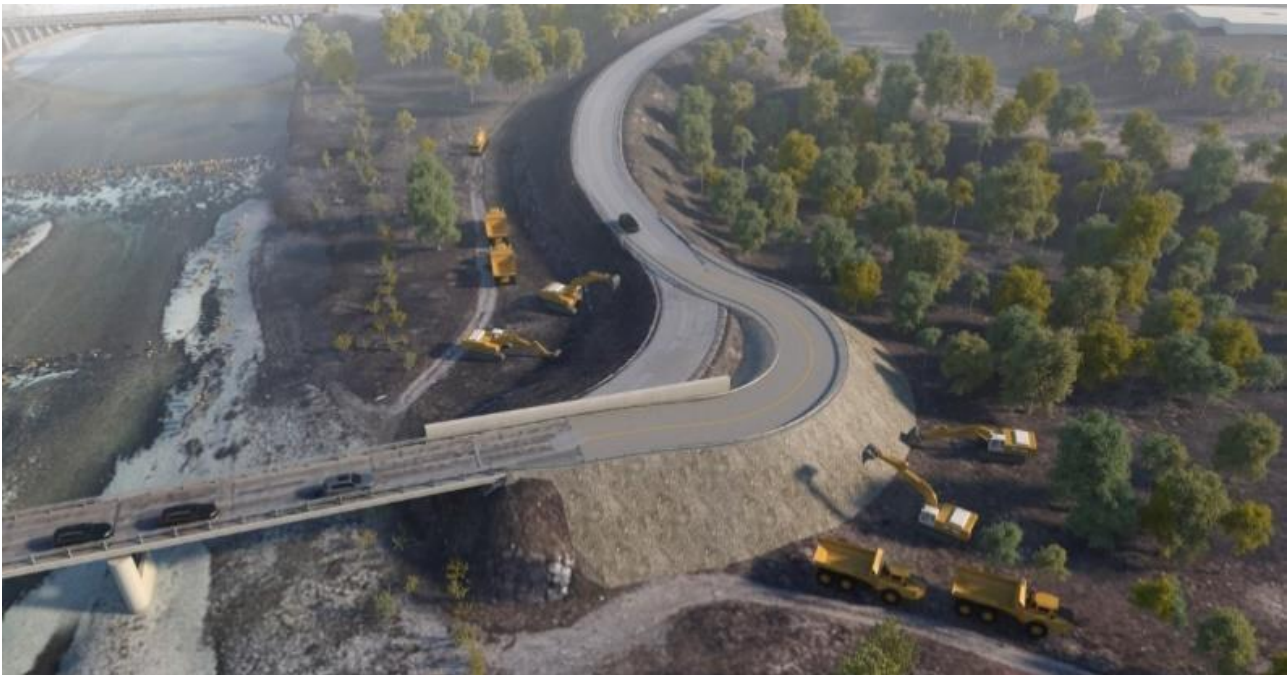
Adeguamento accesso ponte esistente
