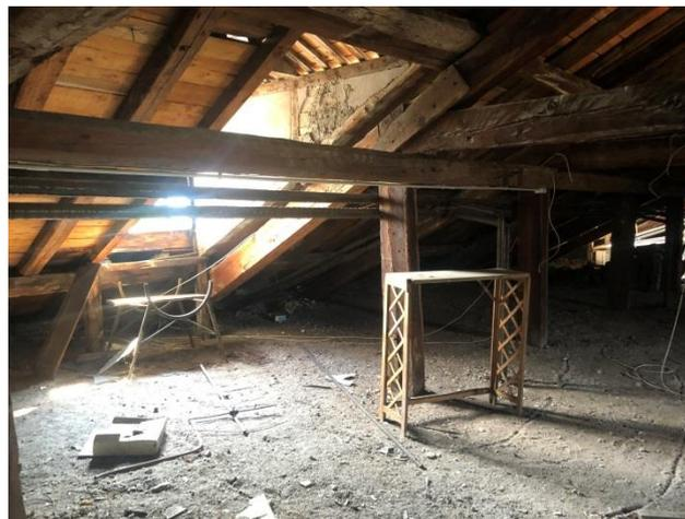
**Figura 15**–Sezione tipologica di una capriata e veduta del sottotetto, con la trave trasversale aggiunta e il rinforzo ligneo di un nodo
