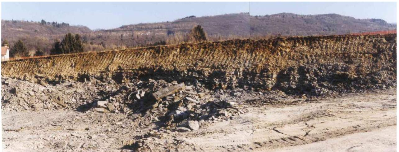
FOTO N.3: scavo eseguito in loc. Levego, in evidenza le Marne, i calcari marnosi e le calcareniti della "Formazione litostratigrafica del Flysch di Belluno" (da Relazione geologica ATER loc. Levego area PEEP - Dr. De Biasi)
