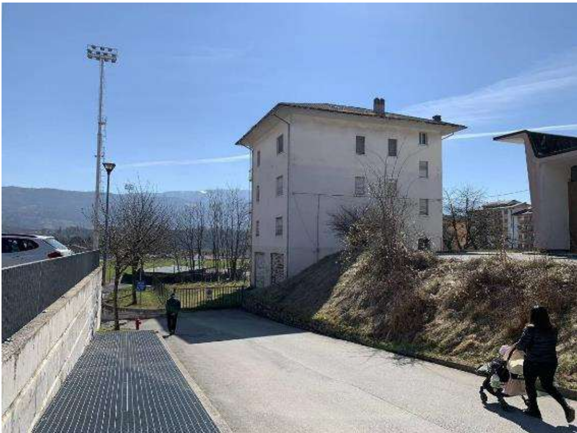
Figura 8 – FOTO 3: Fabbricato fatiscente a quota inferiore
