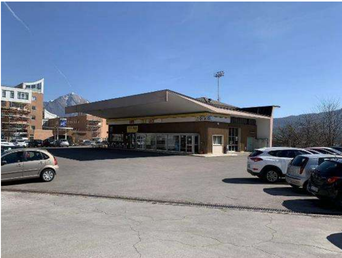
Figura 10 – FOTO 5: Pensilina Agip ancora non demolita
