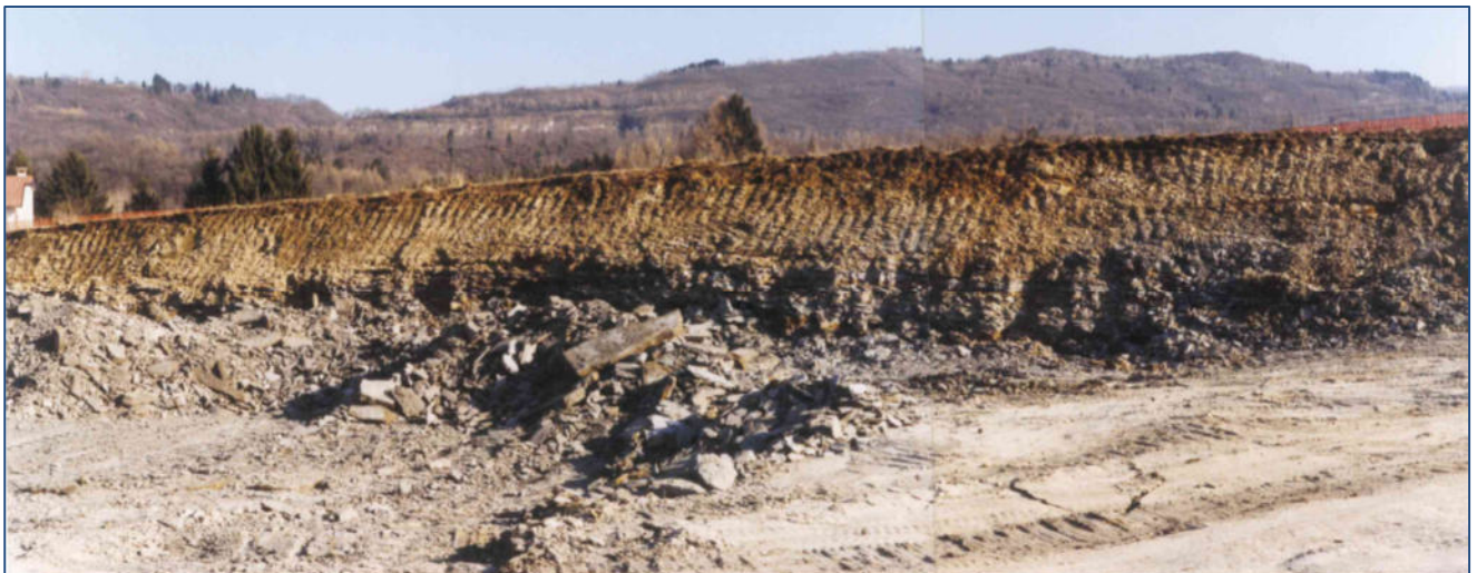
Figura 41 – scavo eseguito in loc. Levego, in evidenza le Marne, i calcari marnosi e le calcareniti della “Formazione litostratigrafica del Flysch di Belluno” (FONTE: Comune di Belluno - Relazione geologica ATER loc. Levego area PEEP - Dr. De Biasi)
