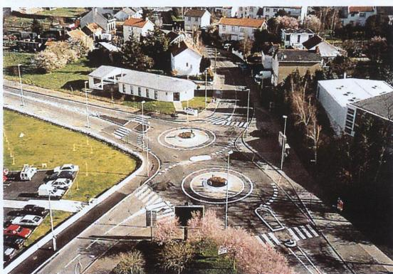
Figura 3.9 - Nantes. Realizzazione di una coppia di rotonde di piccole dimensioni (Diametro esterno circa 26m)Fonte. Y. Le Gal
