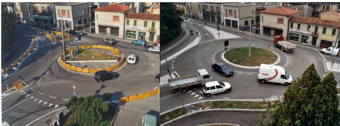
Figura 3.7 - Rotatoria di Via Pontevigodarzere a Padova. Diametro 32m. Flusso 3.800 veic/h
