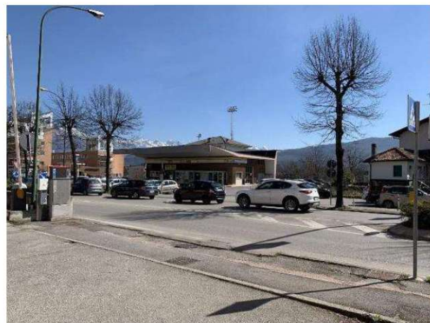
FOTO 6: Tratto di strada oggetto di Piano
