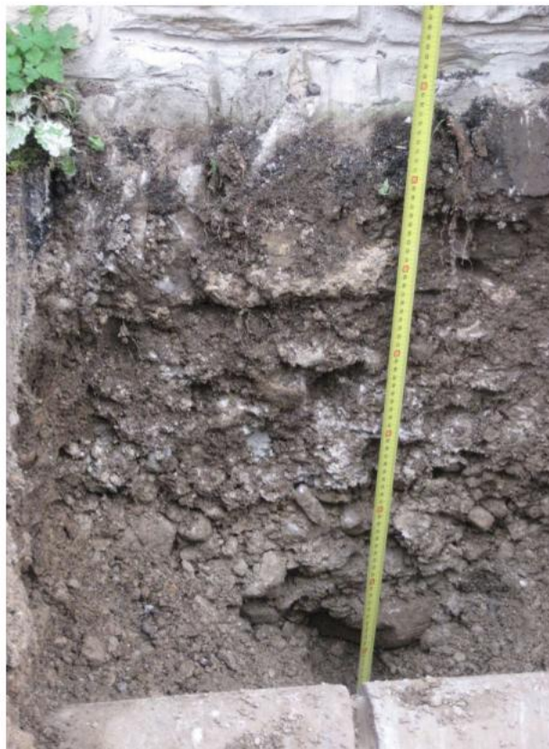
Foto 3 – Dettaglio dello scavo esplorativo a tergo del muro perimetrale
