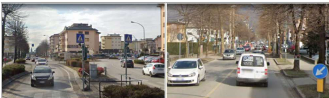
Figura 2.5 - Via Vittorio Veneto – tratto nord-est. A sinistra vista in direzione della rotonda di intersezione con via Medaglie d'oro; a destra nel tratto a sezione più ristretta.
