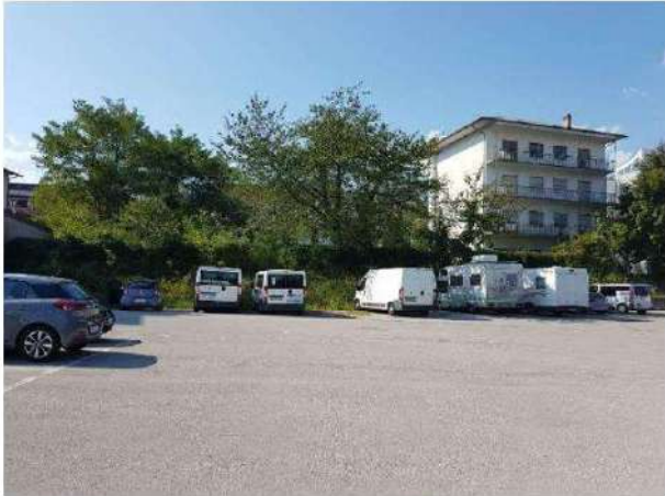
FOTO 1: Ambito di Piano con vecchi edifici ed aree verdi incolte
