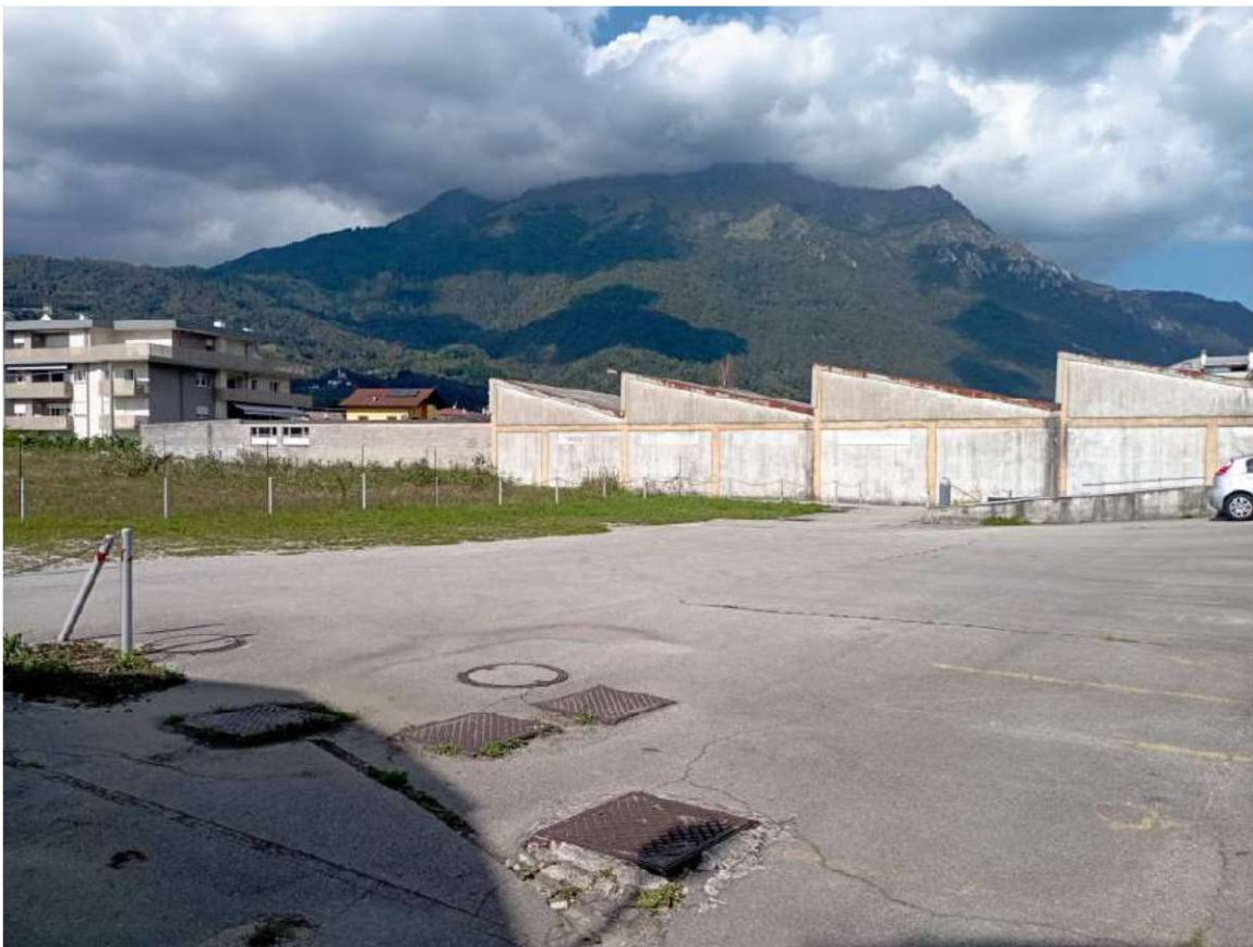
Foto 2: Vista dal lotto verso lo stabilimento “De Mas”.
