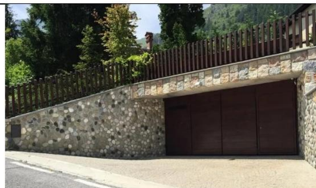
Fig. 5 – accesso ad autorimessa privata
